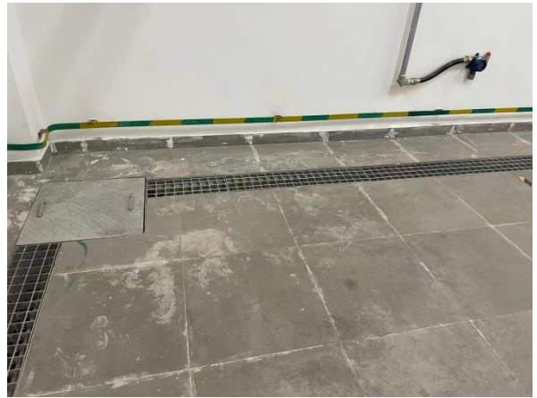
防腐地面、导流槽和收集池
